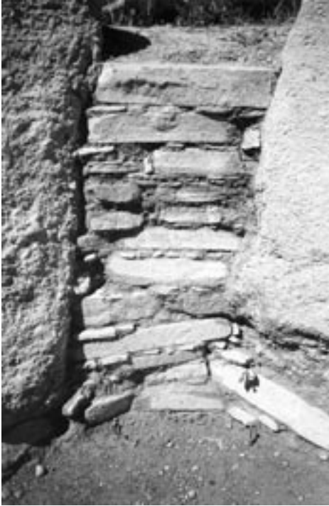
5. Detalle de la mampostería de la Cámara.
