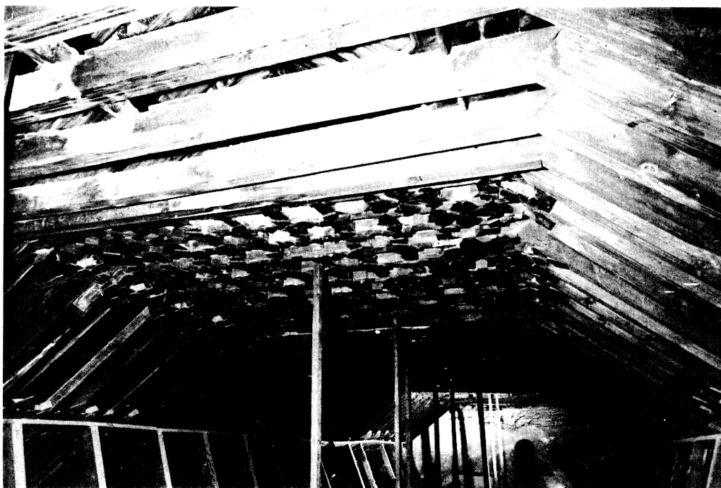
Lámina III. Vista de la armadura hacia la cabecera.
